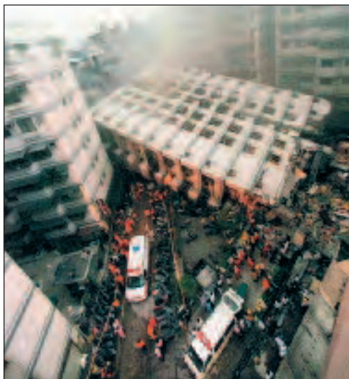
Bloque de apartamentos de Taiwán que se derrumbó con el terremoto de 1999
